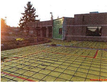
Exterior progress Slab prepped for pour
